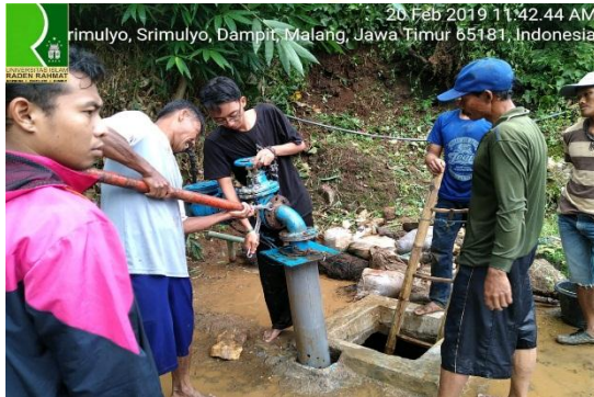
Gambar 3. Proses Pemasangan Kembali Pompa Air yang sudah Diperbaiki
