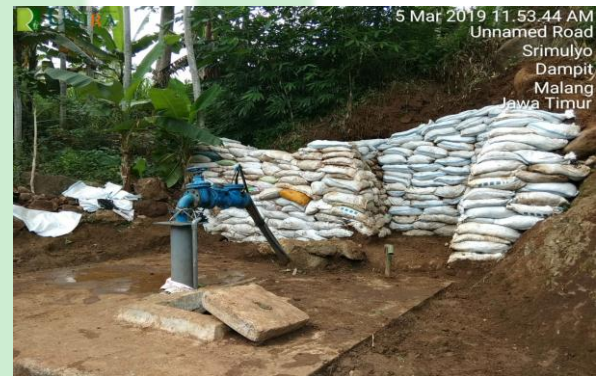
Gambar 5. Pembuatan Dinding Penahan Longsor 90%
