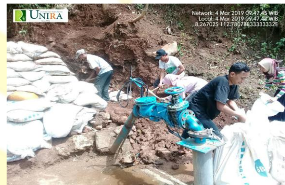
Gambar 4. Proses Pembuatan Dinding Penahan Longsor
